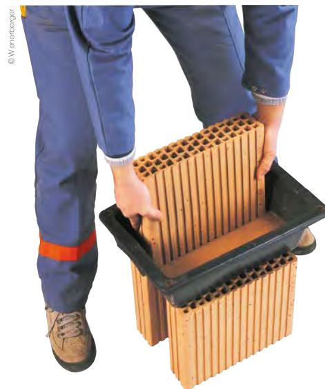
3 - Si vous n'avez pas de rouleau, trempez les briques dans le mortier-joint.
