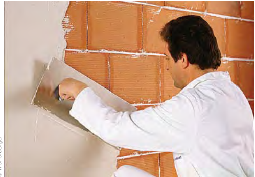
2 - Taloches le plâtre afin d'obtenir une surface unie et plane.
