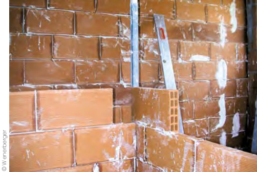
Chaque rang doit être imbriqué dans l'autre. Veillez à décaler les joints verticaux d'un rang à l'autre.
