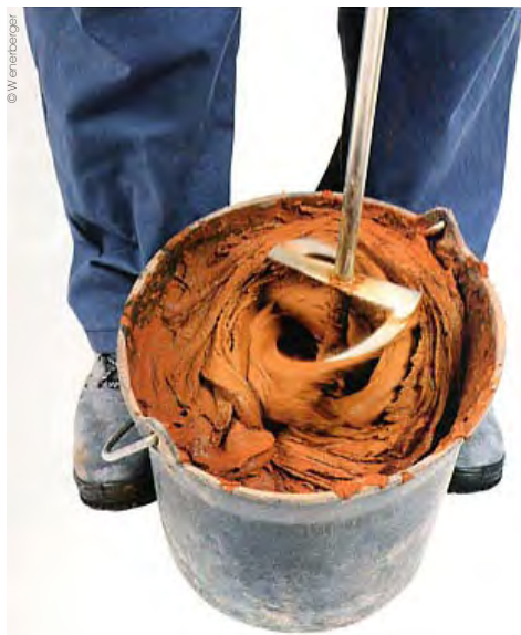
1 - Mélangez le mortier-joint au moyen d'un malaxeur, jusqu'à obtention d'une crème épaisse.
