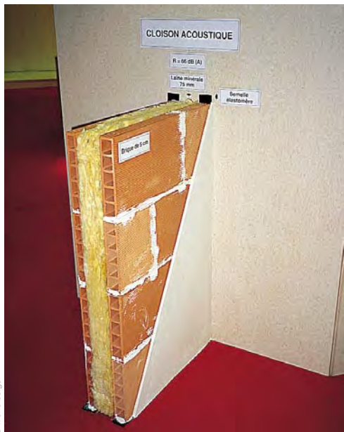
Cloison isophonique renforcée et désolidarisée, composée de deux parois en briques et d'un isolant
