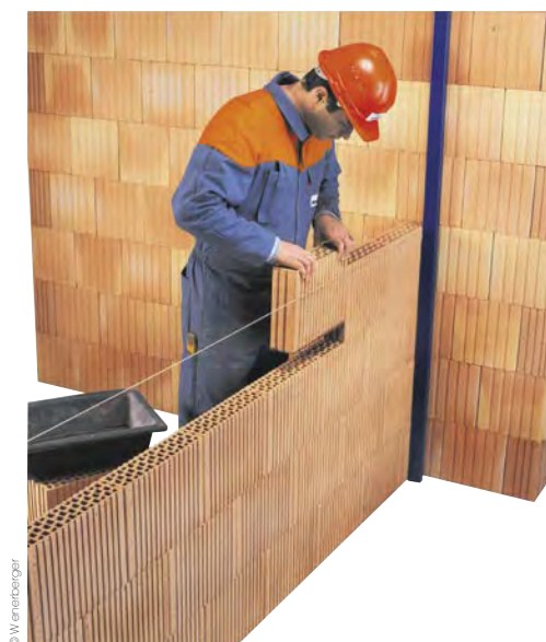
4 - Faites glisser chaque brique, en partant du haut de la dernière brique posée, jusqu'au mortier-collé.
