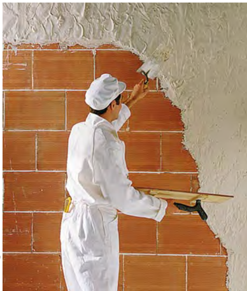
1 - Appliquez le plâtre en le projetant au moyen d'une truelle. C'est le gobetage.
