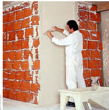
3 - Lorsque le plâtre commence à prendre, grattez-le avec une truelle ou une règle.
